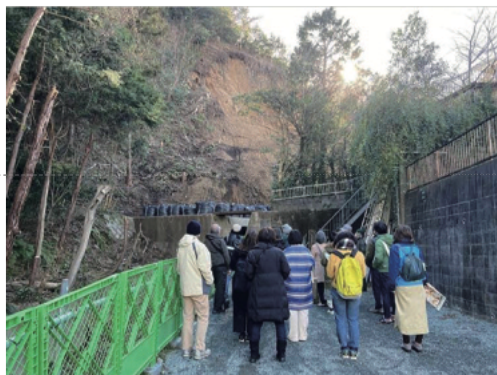
写真 14 2021 年 7 月台風時の土砂崩れの現場
