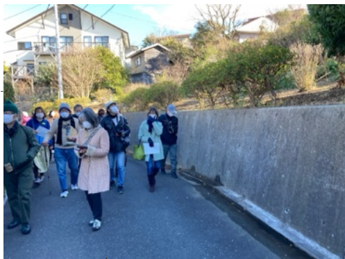
写真 10-1 擁壁の下の水抜きから 常時地下水が出ている。
