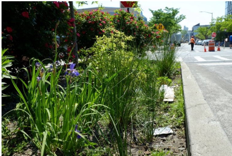
ニューヨーク市・ゴワナス運河周辺のグリーンインフラ整備事例。雨水を受け止め、浸透・浄化しながらゆっくりと流す都市型の水循環システム（Bioswale バイオスエル）を取り入れている。
