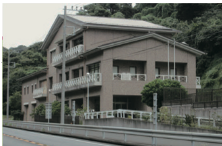
葉山町の長柄地区、逗葉新道料金所近くにある葉山浄化センター。
